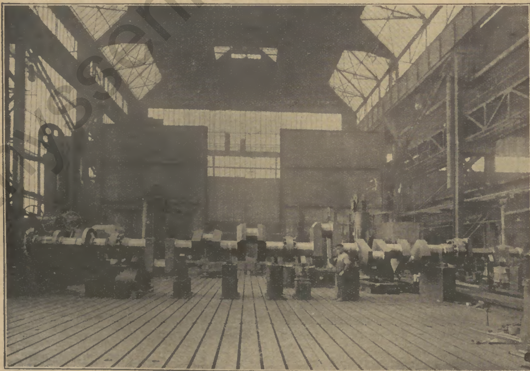
Neunhubige Kurbelwelle für eine 4000 pferdige Schiffs-Dieselmachine.
