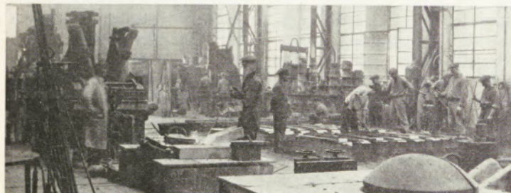
Blick in die Schmelzhalle mit lebhaftem Formbetrieb Mitte 1930
