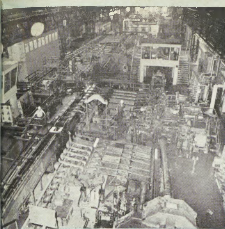
Gesamtansicht der neuen Rohrwarmstraße
