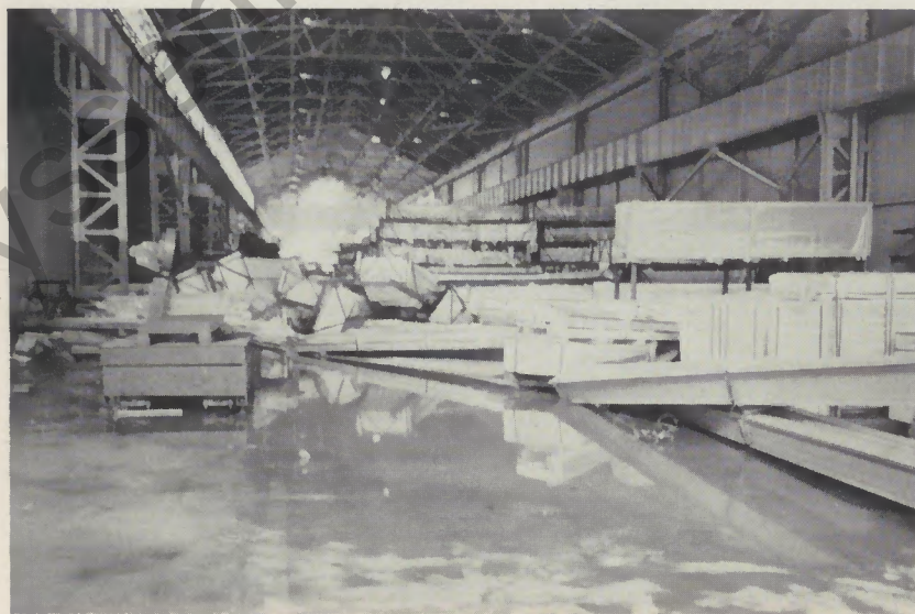
Bild oben: Wasserdurchbruch durch die Hochwasserschutzmauer am Bauteilwerk.
