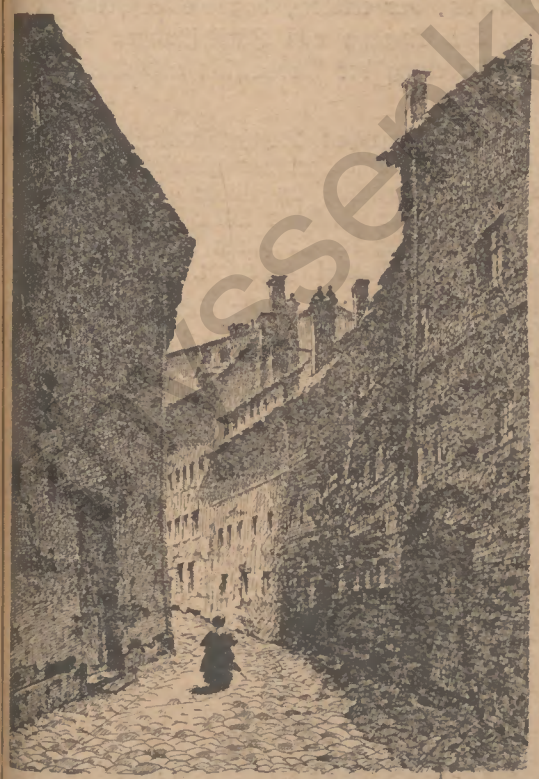
Am Krögel. Der „Krögel“ ist eine alte Gasse am Mollkenmarkt. Die unteren Räume der Häuser dienen noch als Werkstätten für Schmiede usw., die oberen sind unbewohnt.
