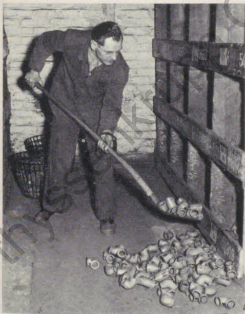
Bild 6 — Rohfittings werden eingelagert
