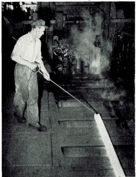
1954 Die Mittelstraße V konnte mit einem Strang wieder in Betrieb gesetzt werden
