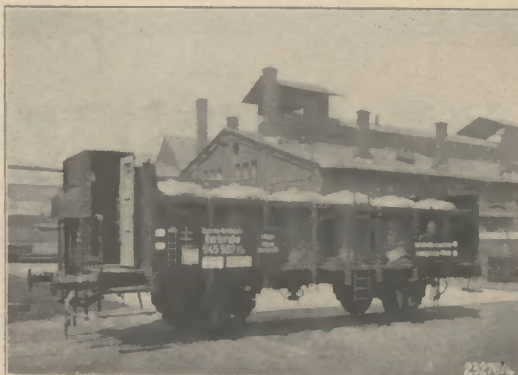
Bild 7: Toppwagen mit 12 eingebauten Steinzeugtöpfen für die chemische Industrie
