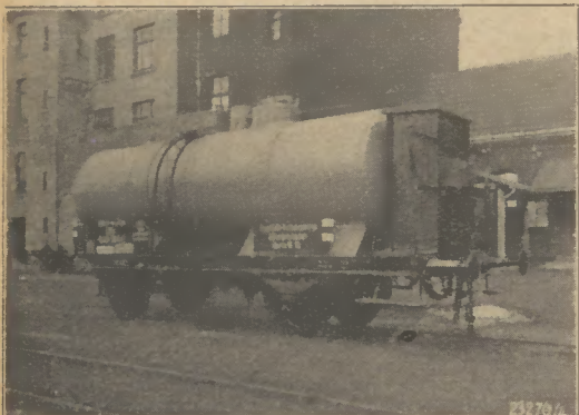
Bild 1: Zweiachsiger Wagen zum Benzin- und Petroleumtransport
