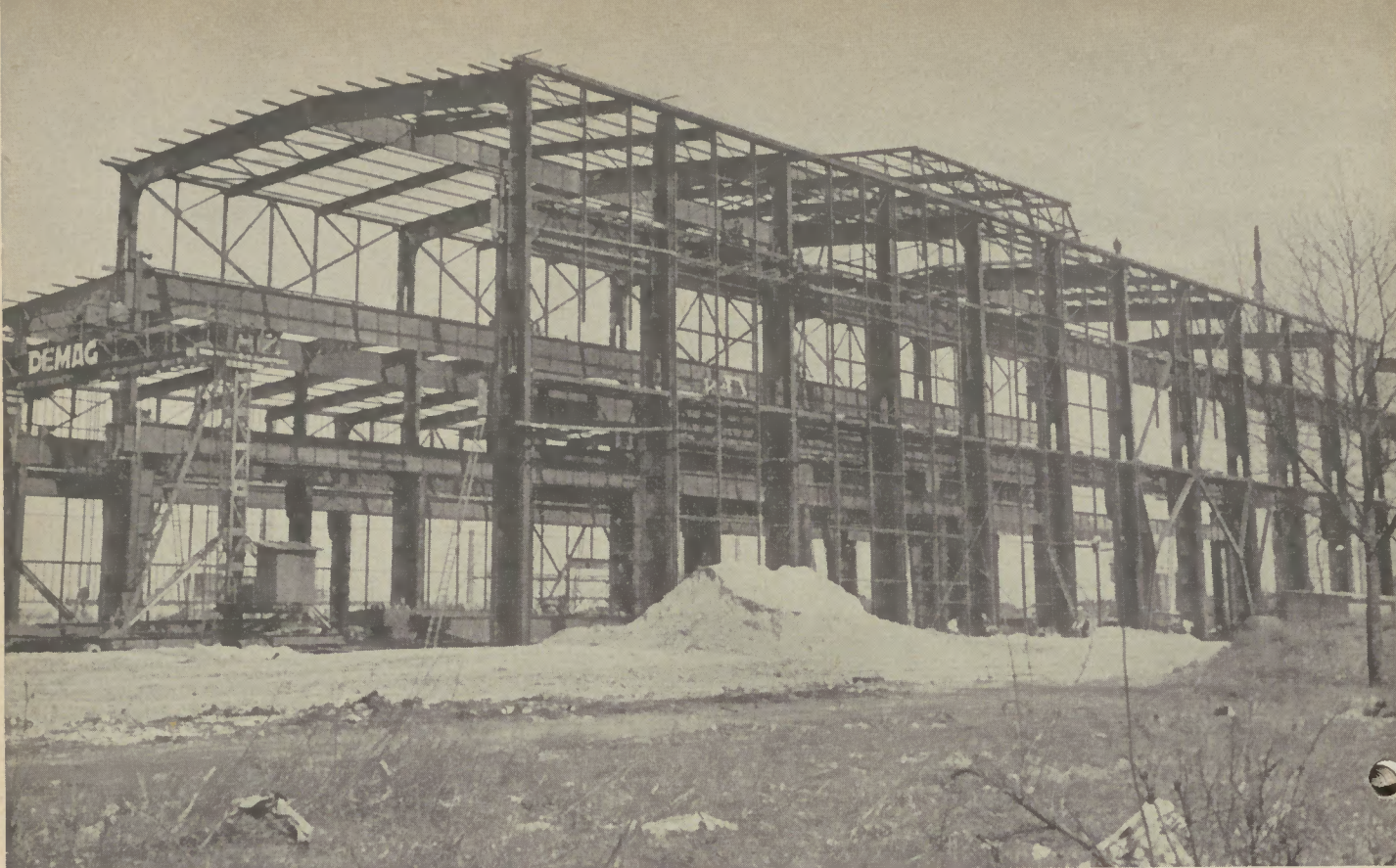
Die Eisenkonstruktionen kurz vor der Fertigstellung.
