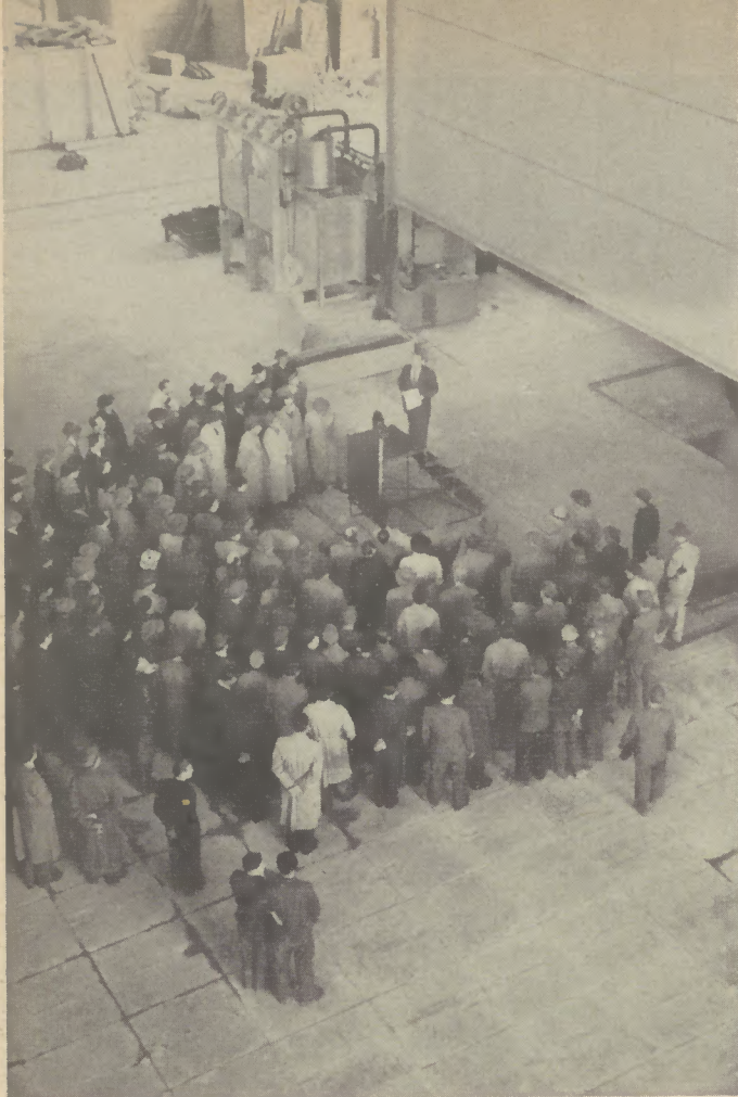
oben: In der neuen Stahlwerksanlage hatten sich am 9. November die Ofenbelegschaft, der gesamte Aufsichtsrat, der Vorstand, die Leiter unserer Betriebe und Angehörige der Baufirmen versammelt, um das Anlaufen des ersten 70-t-Elektroofens für die Erschmelzung von Edelstahl in Europa mitzuerleben.
