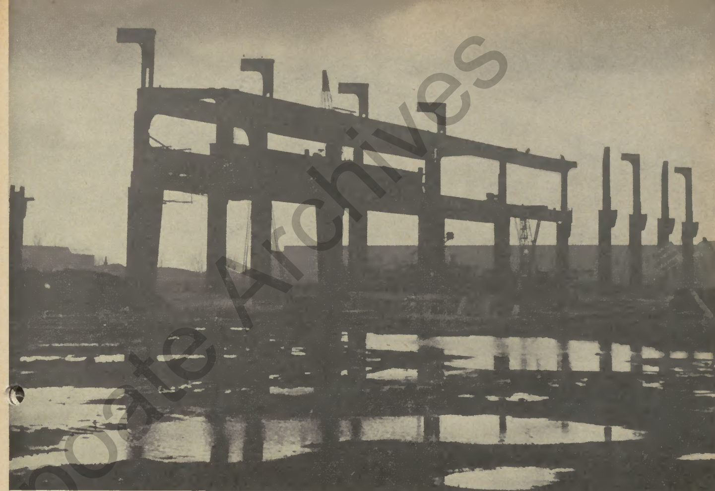
oben: Im Laufe des Winters 1954/55 wurde mit der Montage der Eisenkonstruktion des neuen Stahlwerks begonnen. Häufig erschwerten Witterungsunbilden die Arbeit, trotzdem wurde sie so zügig durchgeführt, daß die Konstruktion im Sommer 1955 fertiggestellt war.
