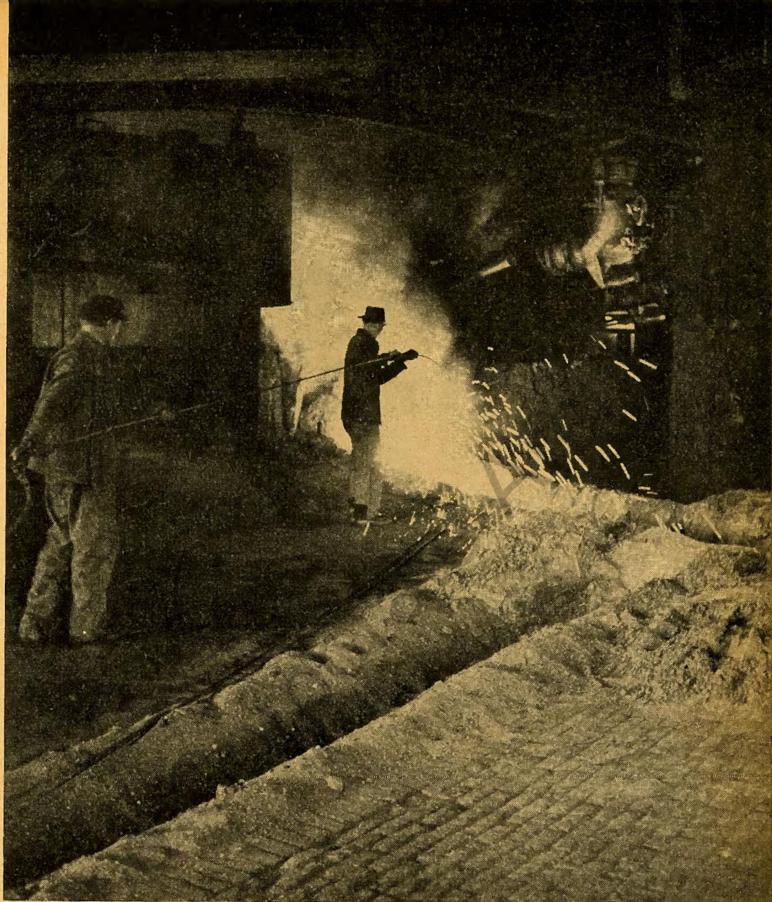
Aufbrennen des Stichloches an einem unserer Hochöfen
