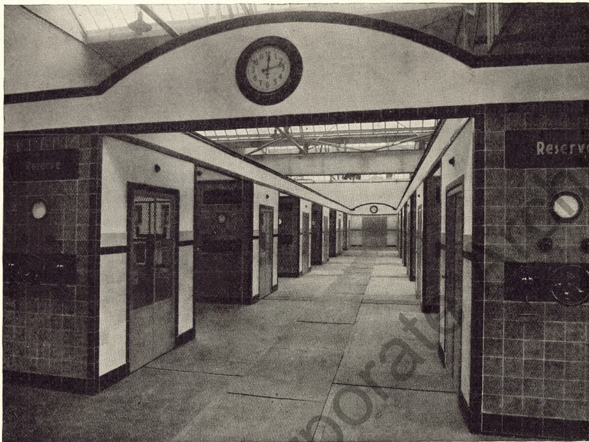
Abb. 5. Blick in das Schalthaus
