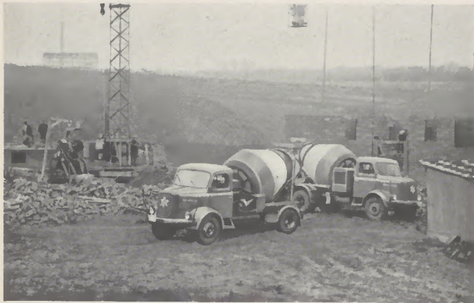
Abb. 14 HS 100, Radstand 3850 mm, als Transportbetonmischer, zulässiges Gesamtgewicht 13300 kg
