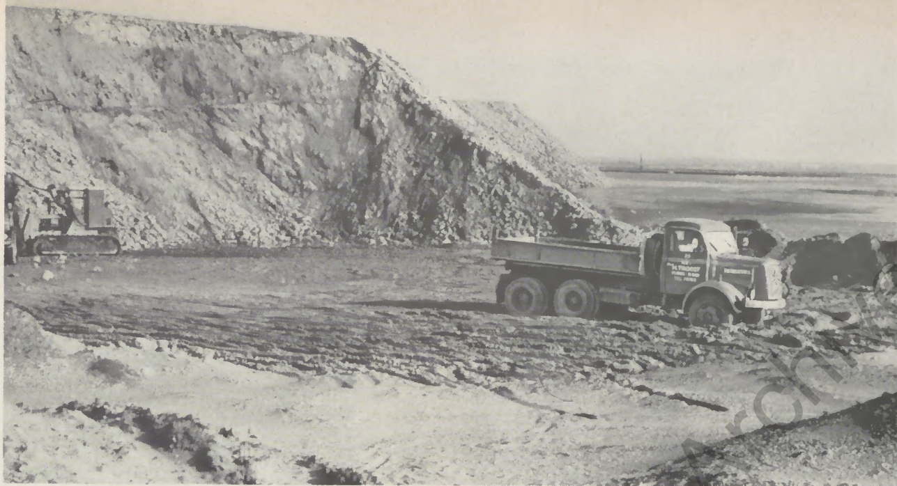
Ein Vorratsberg aus Trümmerschutt und Erde für den Deichbau. Im Vordergrund ein HS 3-125
