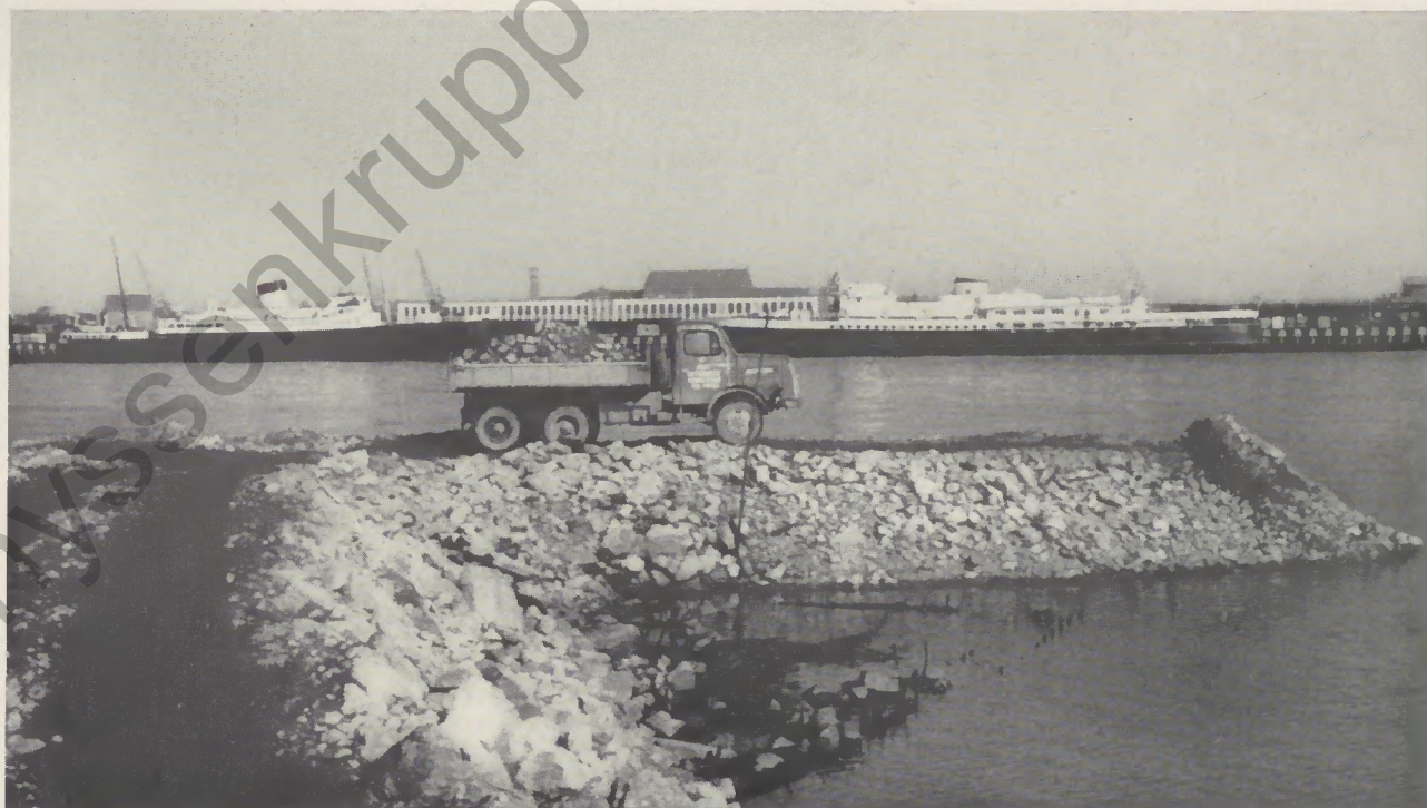
Ein HS 3-125 beim Transport von Material zum Aufwerfen der Deiche. Da für die Deiche möglichst festes Material bevorzugt wird, verwendet man, soweit vorhanden, Trümmerschutt.
