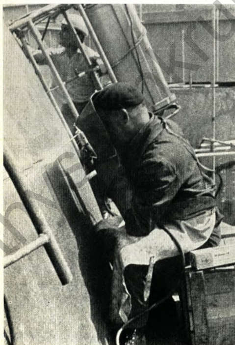
Ein Schweißer an einem Kugelbehälter in Bremen schweißt die obere Rundnaht von außen. Im Hintergrund der Röntgen-Techniker mit dem Röntgen-Gerät.
