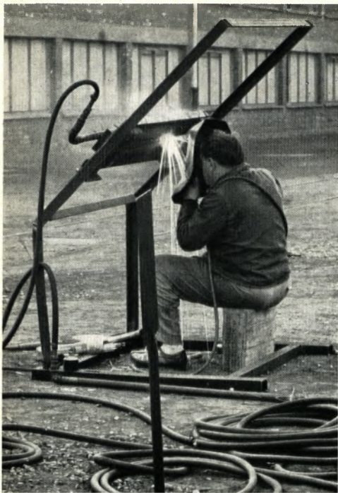
Bei einem Vorversuch im Werk Köln der Pintsch-Bomag AG vor dem Bau der Kugelbehälter in Bremen: Der Schweißer arbeitet in schwieriger Position bei höchsten Anforderungen an Nahtstücken in Originalgrößen.
