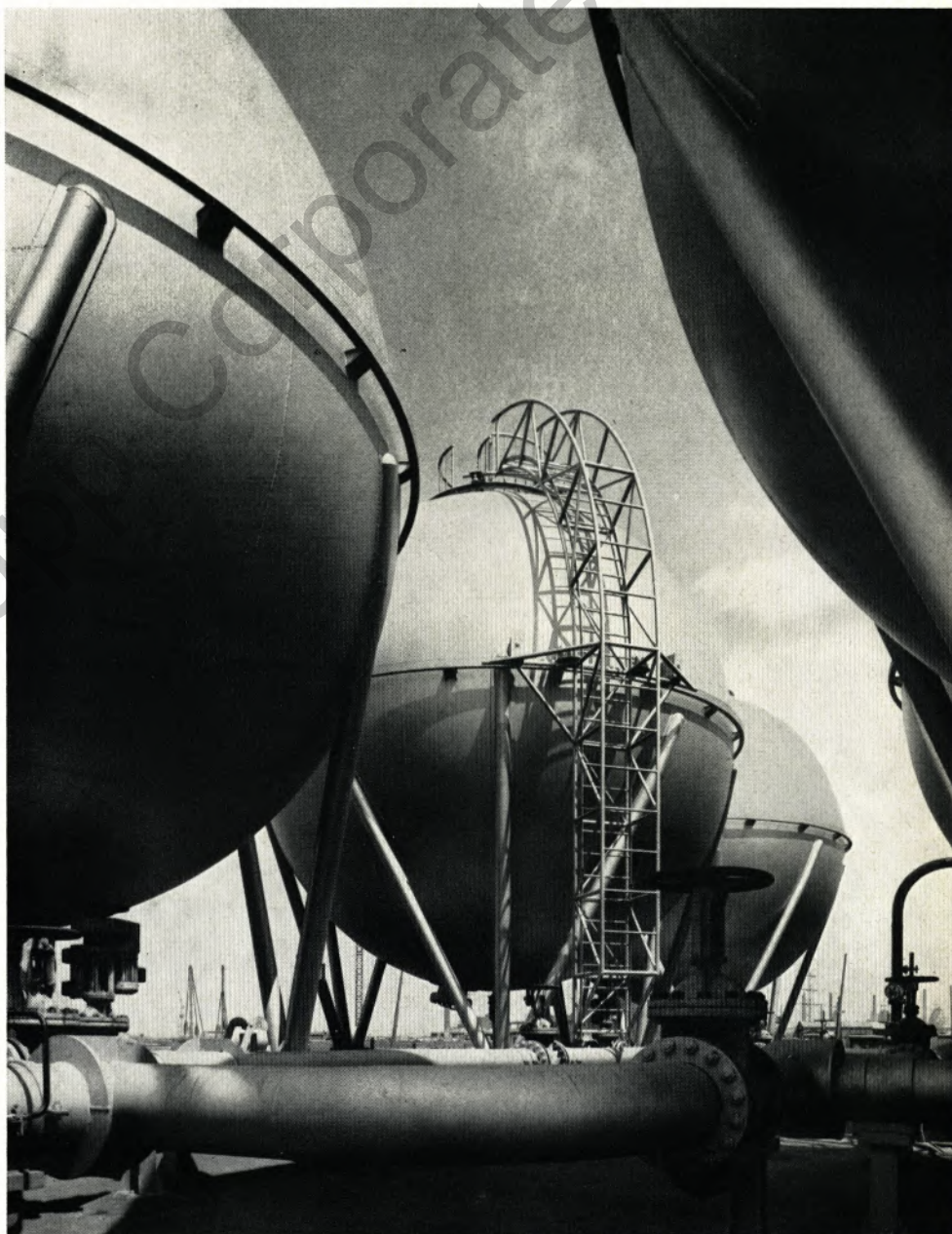
Die Kugelbehälter für Sauerstoff-Lagerung in dem neuen Oxygen-Stahlwerk der August Thyssen-Hütte in Duisburg-Beeckerwerth, von der Firma Aug. Klönne (Dortmund) gebaut, wurden mit WU-Elektroden geschweißt.
