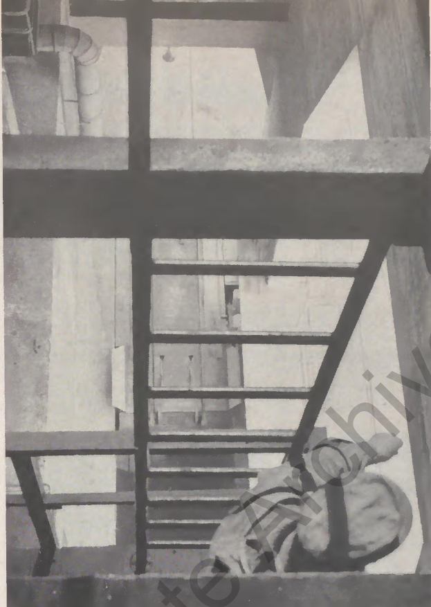
August Boerger blickt von seinem Kranfahrerhaus „unter'm Dach“ vom Kesselhaus Mittelfeld in mehr als 30 Meter Tiefe hinunter.
