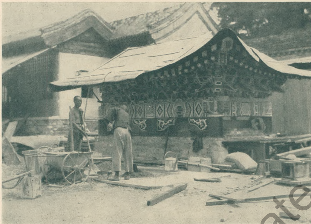
Chinesische Maurer bauen einen Teil des Daches für die neue Staatsbibliothek in Peking, die nach den Plänen eines deutschen Architekten errichtet wird.
