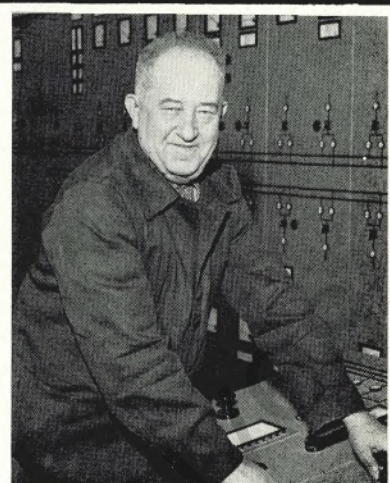
RUDOLF BEIMBAUER, Oberschalttafelarb. Elektro-Zentrale u. Str.-Vertr. — 22. April
