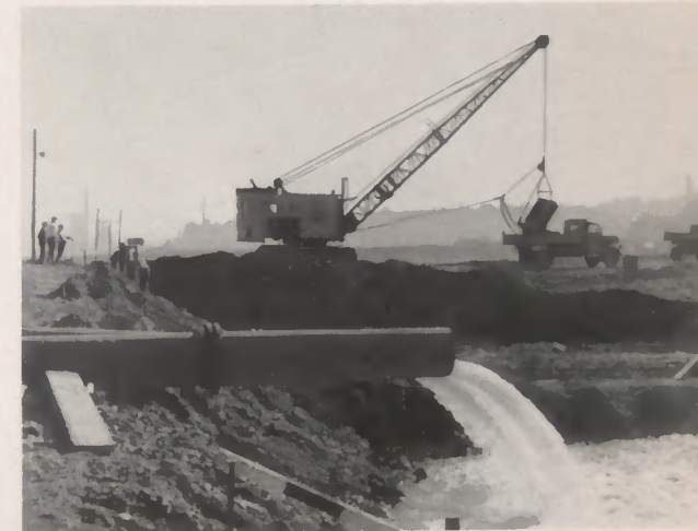
Endphase der Ruhrverlegung: Nachdem die Bauaufsichtsbehörde die Ruhrverlegungsarbeiten abgenommen hatte, wurden am 3. Oktober die Pumpen, die bis dahin das im neuen Ruhrbett steigende Grundwasser abgepumpt hatten, stillgesetzt. Das neue Flußbett der Ruhr ist damit fertiggestellt. Unsere Aufnahme entstand am 2. Oktober und zeigt ein Pumpenabflußrohr, das Grundwasser aus dem neuen Ruhrbett in die alte Ruhr überleitet. Im Hintergrund ist ein Bagger-kran damit beschäftigt, den unteren Riegel – vorbereitend zum Durchstich – zu verschmälern.
