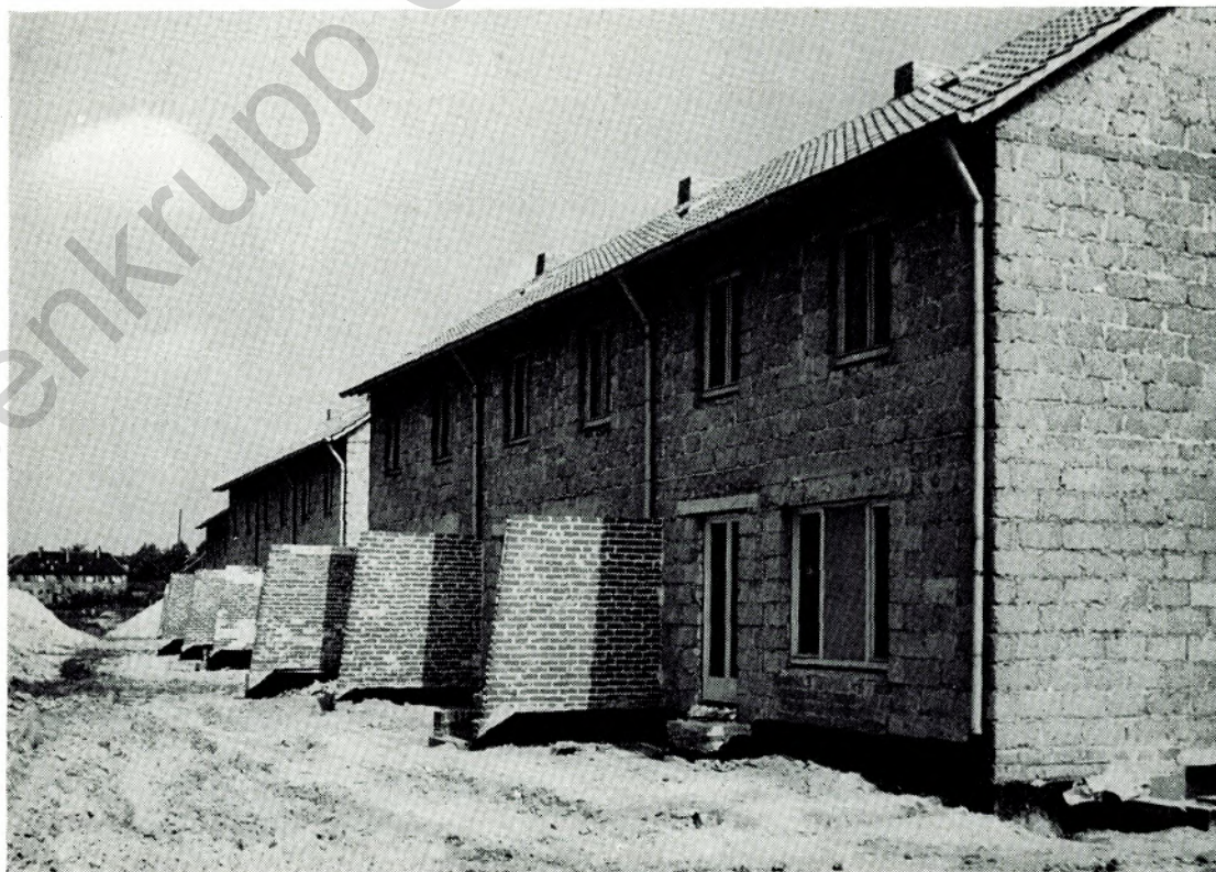
Nur der Verputz fehlte noch Anfang Juni an den Häusern in Walsum. Die Gebäudeaufteilung, wie bei dem Modell, ist nach der Gartenseite hin, wo sich hübsche kleine Terrassen anlegen lassen, schon deutlich erkennbar.
