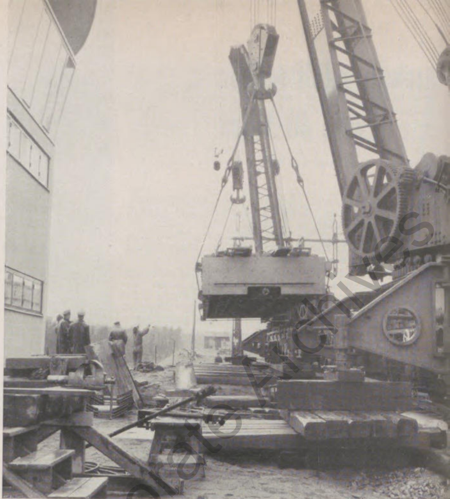
Mit mächtigen Kranwagen — auf diesem Bilde in Schweden — wird die Thyssen-Gleisbremse an der Montagestelle von den Eisenbahnwaggons gehoben und eingebaut
