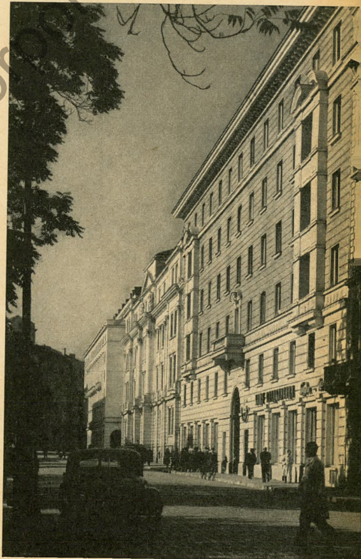
Neue Bauten in Sofia (Molotowstraße)
