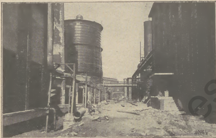
Kühlturm, der 6000 cbm Gasometer, die elektrische Kraftzentrale, Ammoniakfabrik, Gastkühler, Maschinenhaus und Benzolfabrik der neuen Großhütte
