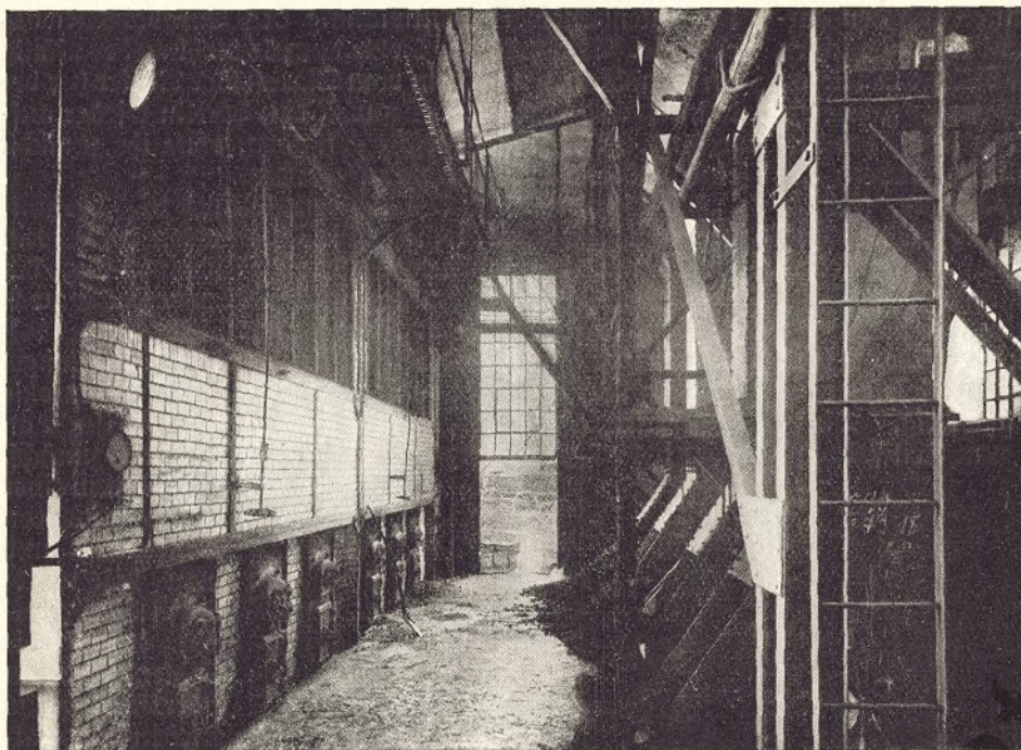
Abb. 4. Steinkohlenwerk Plöb — Kesselhaus
