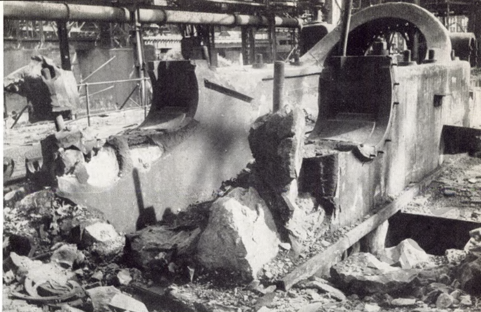
In der Gaszentrale, in der einige Maschinen demontiert werden sollten, gingen die Demonteure mit Sprengstoff ans Werk. Was übrig blieb, war Schrott
