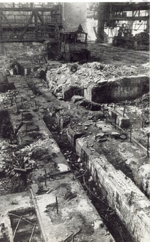
Von Maschinen entblößte Hallen des Elektro-Stahlwerkes I. Auf den Fundamenten steht nicht ein einziges Stück der Einrichtung mehr
