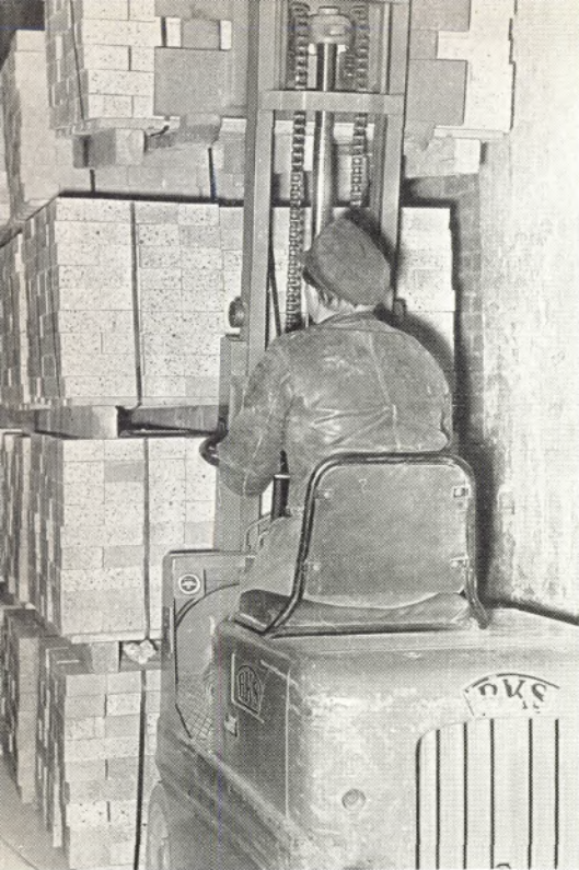
Der moderne Gabelstapler, den Helmut Schöneberg fährt, erleichtert Stapeln und Verladen der fertig gepackten Paletten. Er hebt das 20 Zentner schwere Steinpaket spielend in die vierte Etage
