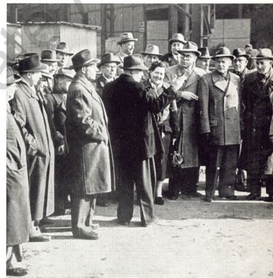
Auch die Mitglieder der Ortsverwaltung Duisburg der Industriegewerkschaft Metall weilten auf dem Werksgelände. Meister Breuer berichtet gerade auf der Baustelle des neuen SM-Werkes von diesem großen Bauvorhaben
