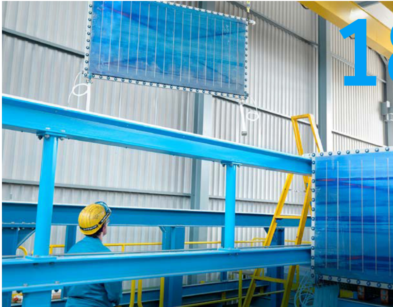
Montage von Elektrolysezellen
