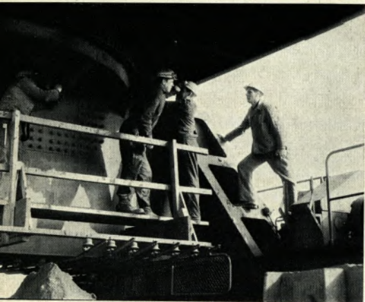
Reparatur am Drehwerk eines Kranes.
