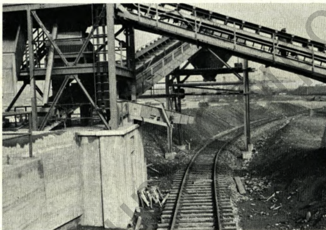
Die Separation mit Sieben, Schrottrutsche und Schrottbunker.
