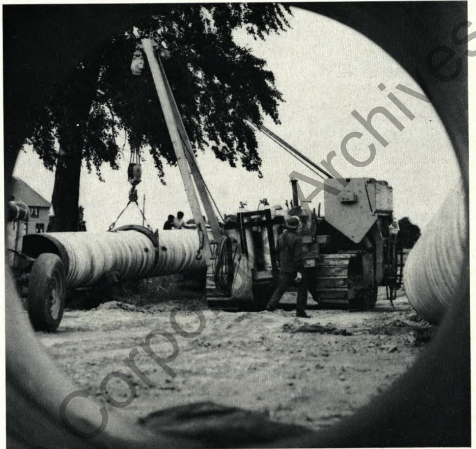
Zur Bewegung der Rohre auf der Baustelle dient ein schwerer Seitenbaumtraktor mit Raupenantrieb. An den Stahlrossen hängt hier ein 4 Tonnen schweres Rohr.
