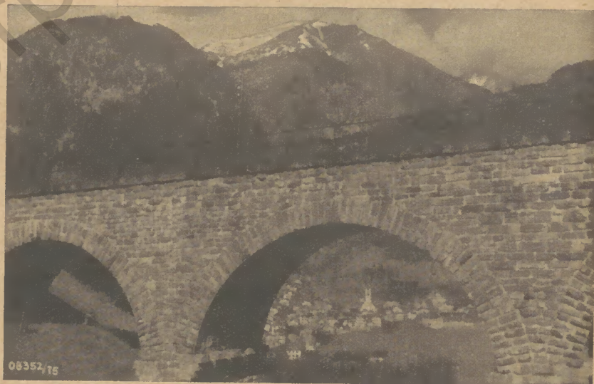
Viadukt der Tauernbahn über die Steinbachschlucht, 78 Meter lang, 31 Meter über Talsohle. Durch den Bogen sieht man Hofgastein
