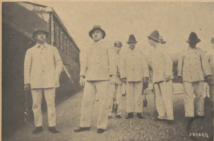
Einfahrt auf dem „Pfannenberg“
