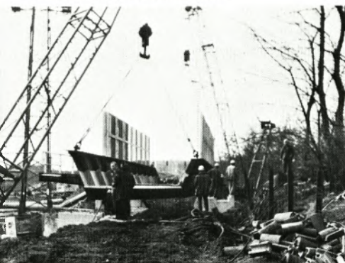
Einschwenken des neuen Überbaues
