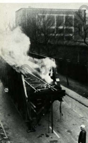
Abtransport der alten Brücke
