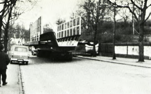
Anfuhr des neuen Überbaues
