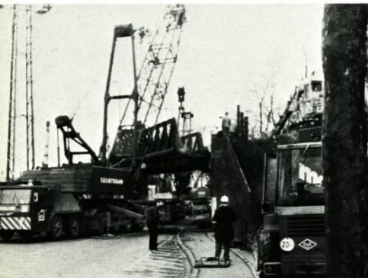
Ausbau der alten Brücke.
