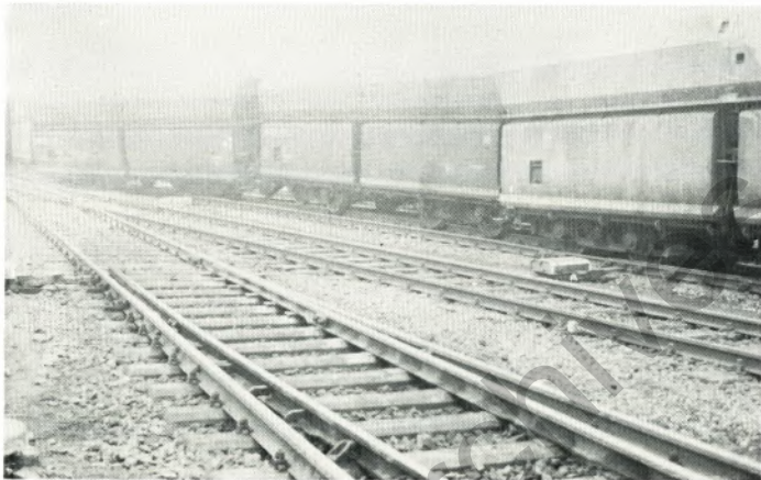
Bei einem Rangierunfall aus nachträglich nicht mehr einwandfrei zu klärender Ursache entgleisten 6 DB-Selbstentladewagen. Schadenskosten ca. DM 22.000,-
