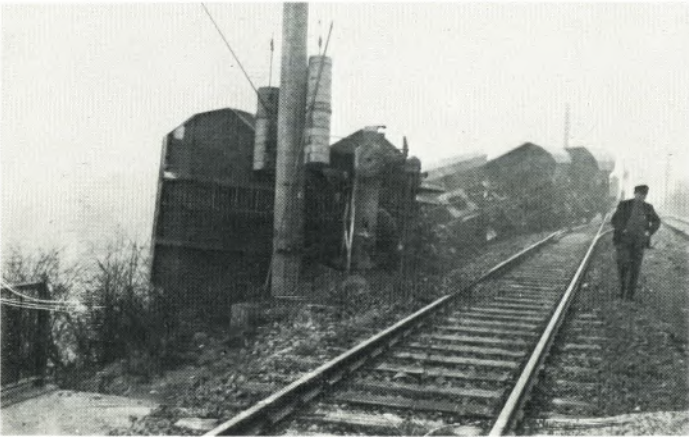
Durch einen Hemmschuh entgleisten 7 Selbstentladewagen der Deutschen Bundesbahn. Schadenskosten ca. DM 12.000,-
