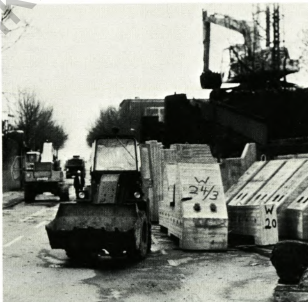
Aushub hinter den Widerlagern und Abbruch der Widerlagerköpfe
