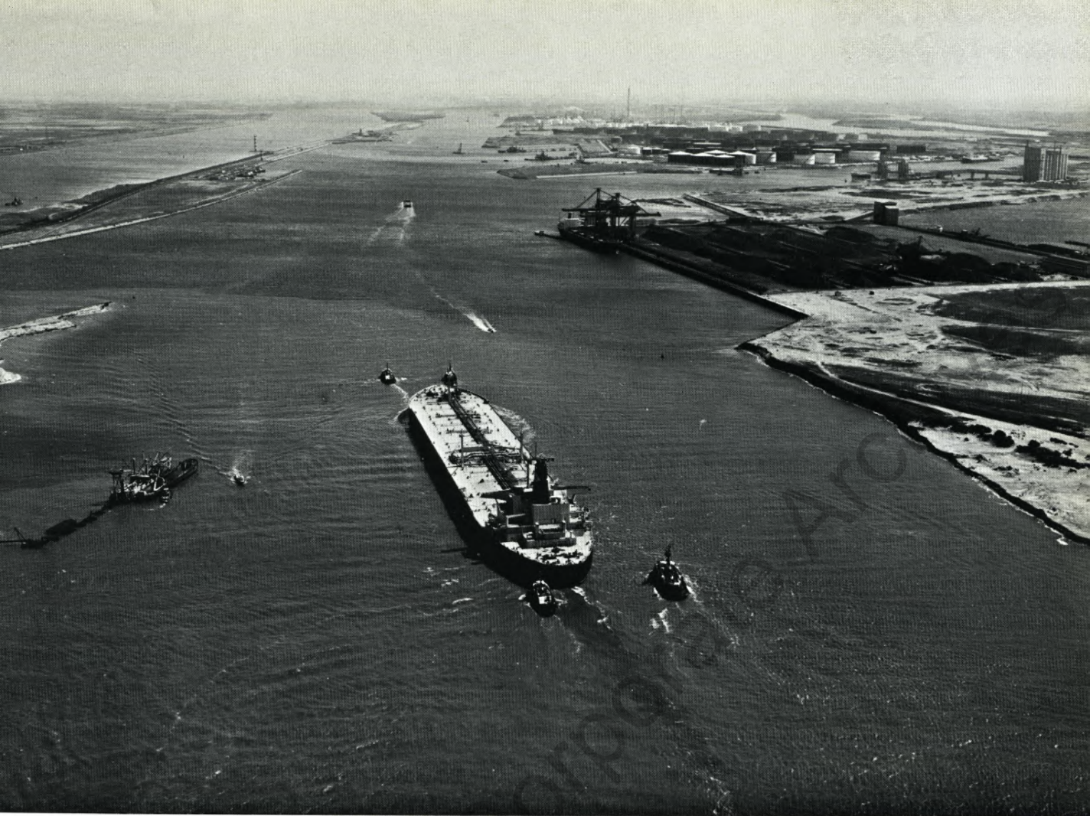
Auf der neuen Einfahrt zu den Rotterdamer Häfen passiert ein Großtanker die Erzumschlagsanlage in Rotterdam-Europoort (rechts); links im Bild der „Neue Wasserweg“.
