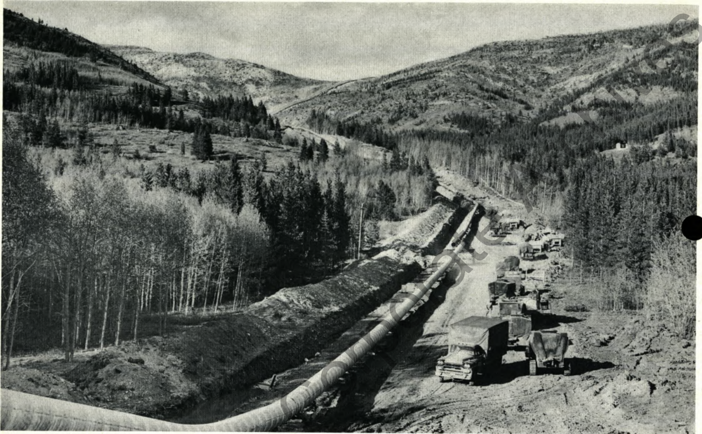
Rohrverlegungen in den Ausläufern der Rocky Mountains in West-Kanada gehörten zu den Aufgaben, die trotz der damit verbundenen großen Schwierigkeiten von unseren Werken in Kanada erfolgreich gelöst wurden.
