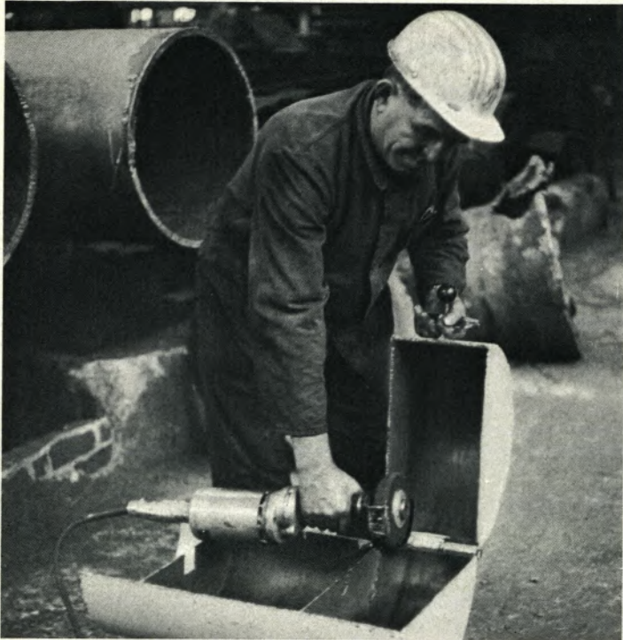
Ein Meister im Werk Düsseldorf ersann ein Gehäuse, das den Probelauf einer Handschleifmaschine gefahrlos ermöglicht. Auf unserem Foto legt Paul Hohnke (Glattrohradjustage, Werk Düsseldorf) eine Schleifmaschine zum Probelauf ein.
