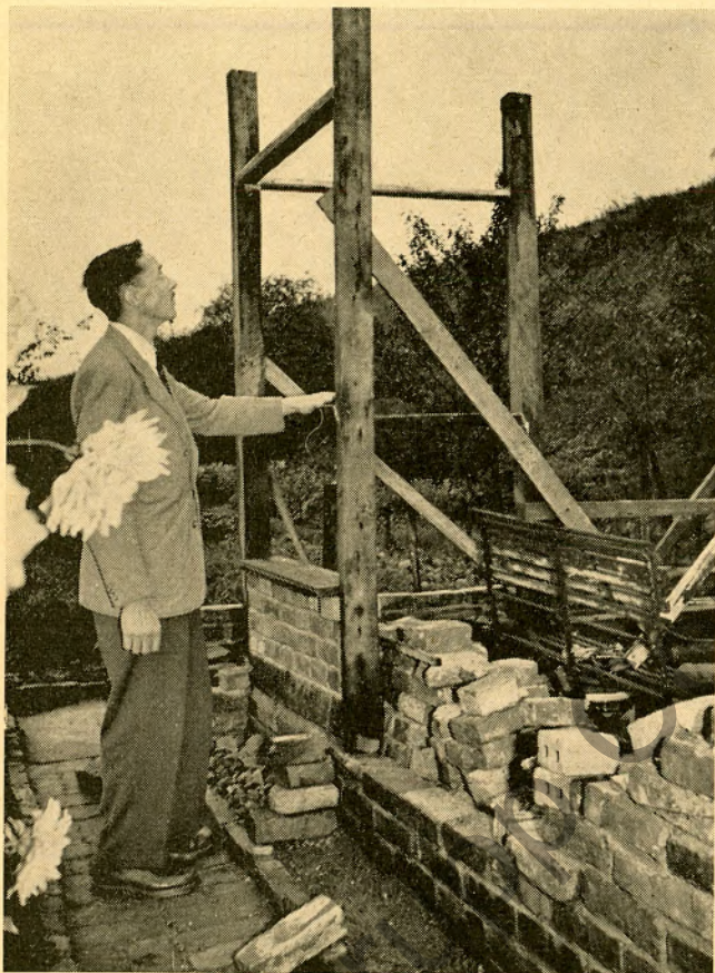
Toplacher vor seiner Laube Fundament und Fachwerkgerüst sind schon deutlich zu erkennen
