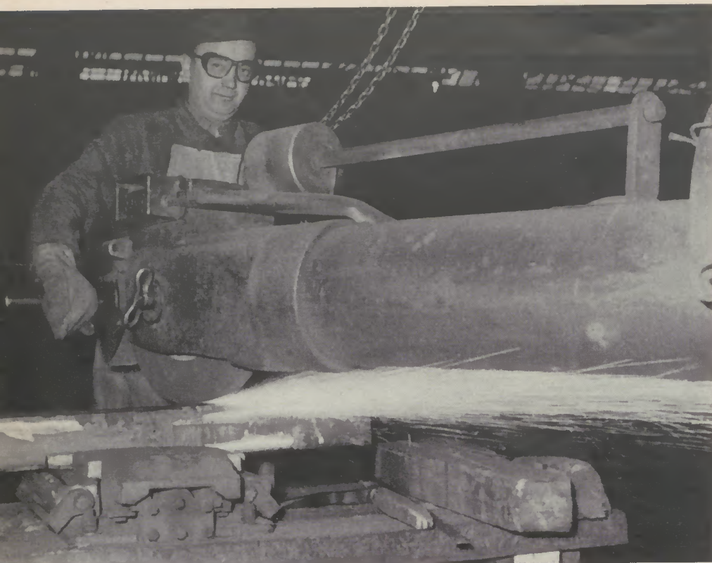
Pendelschleifer Otto Schelert beim Knüppelschleifen im Walzwerk
