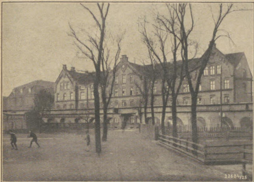
Das frühere Ledigenheim der Hütte Phoenix. Im Vordergrund die Hochbahn, dahinter das Hauptgebäude, links das jetzige Kinderheim
