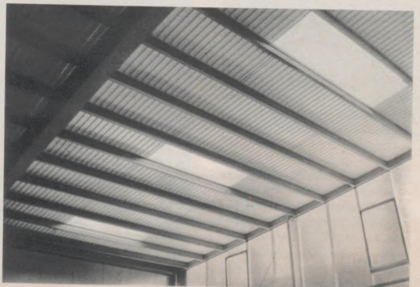
▼ Stahl-Normhalle mit Dach aus Tektal und Wänden aus Hoesch-isowand
