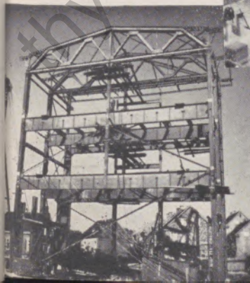
Die Errichtung der Eisenkonstruktion
