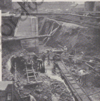
Tiefe der Fundamente
