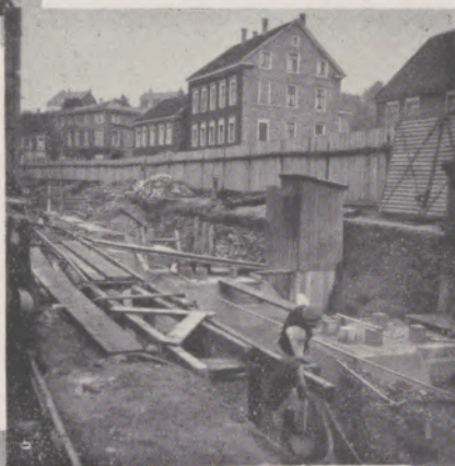
Ausschachtung der Fundamente
