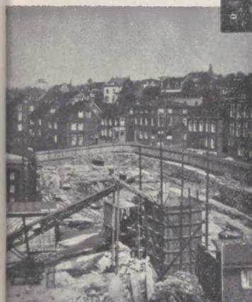
Abuschung der ersten Fundamente
