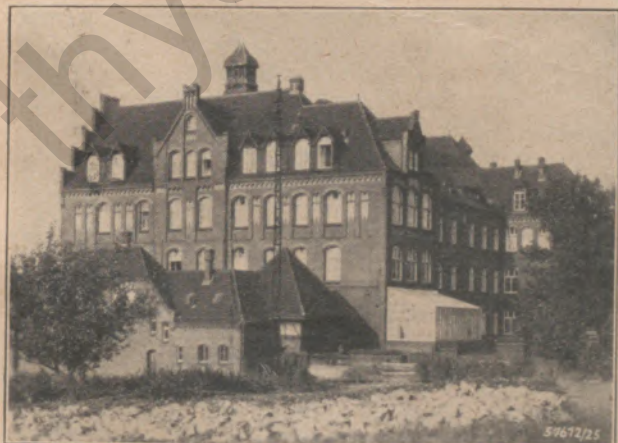
Abb. 3: Neues Hüttenhospital von Südwesten gesehen
