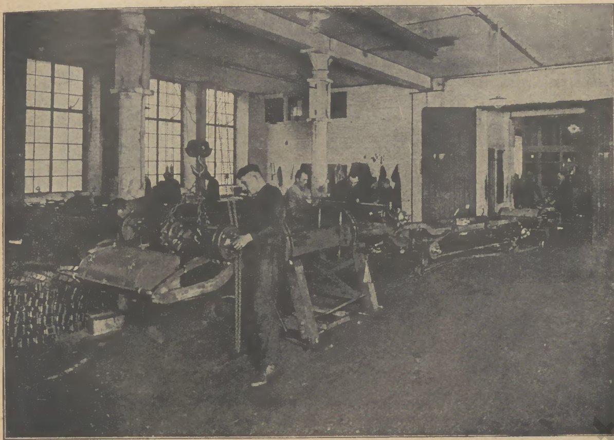
Montage des Chassis.
