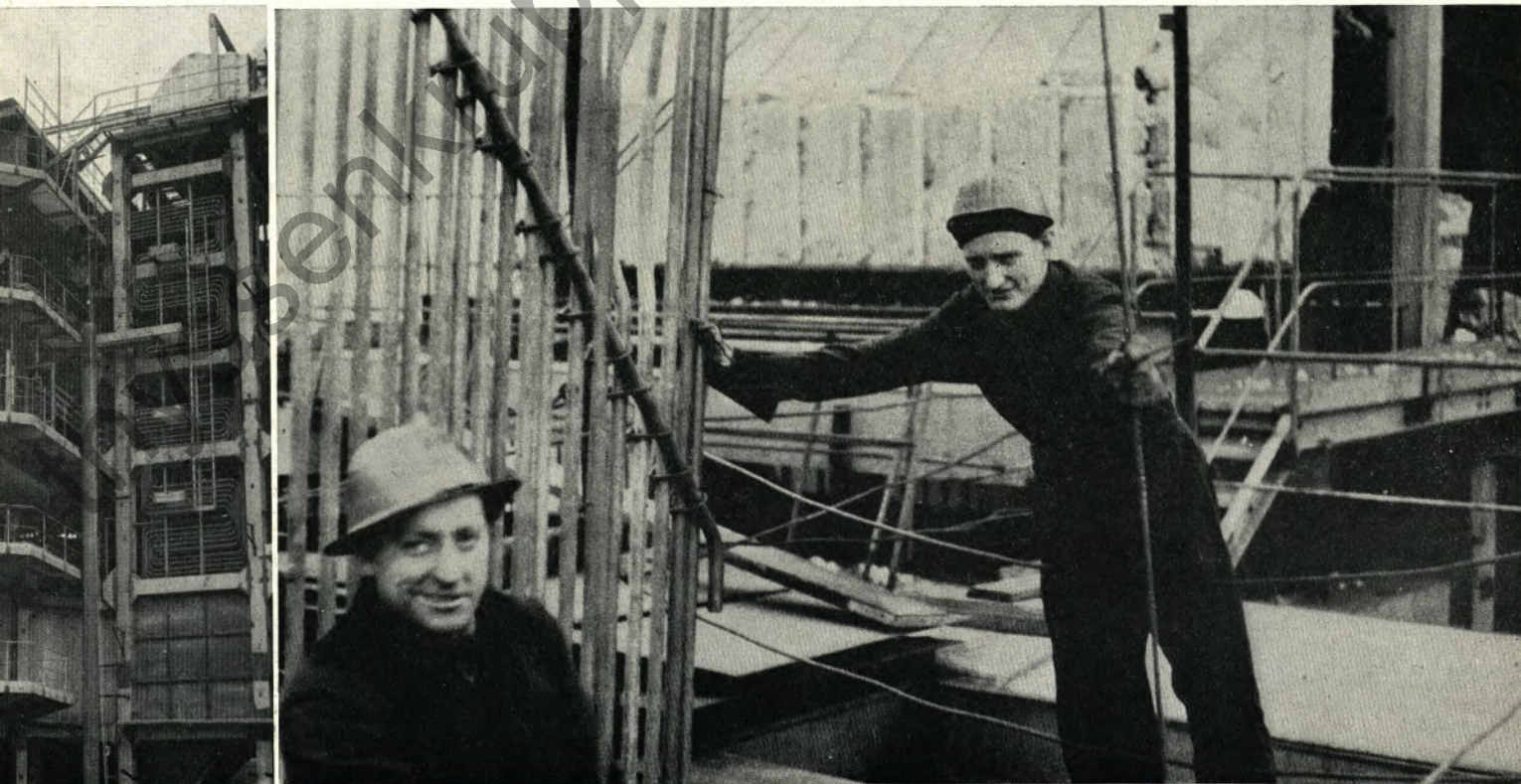
Zwei Monteure fügen ein Rohrregister von oben in den Strahlungsteil des neuen Oberhausener Heizkraftwerkes ein
