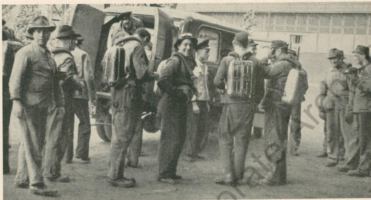
Fertigmachen zum Arbeiten im gasgefährdeten Bereich
