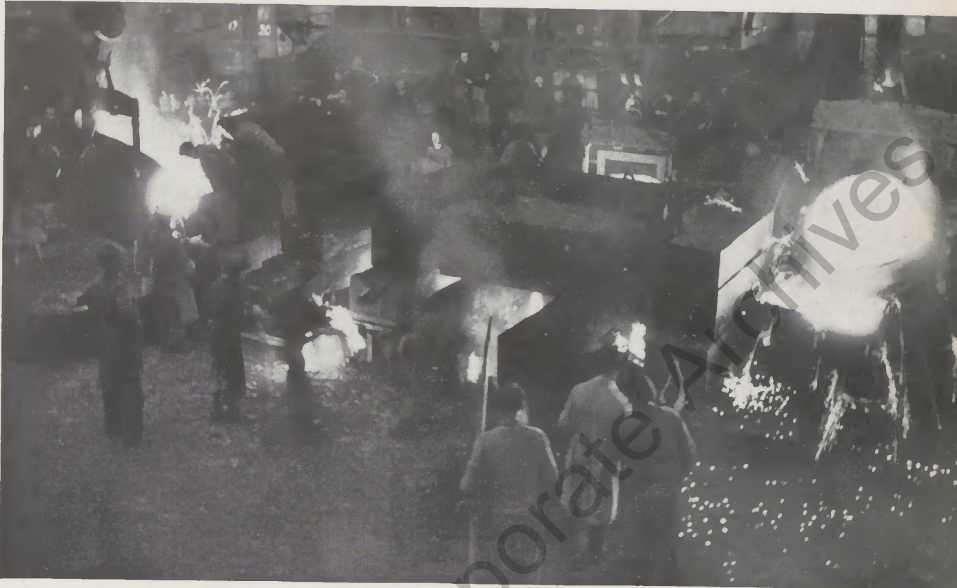
Abb. 1 Abguß eines Großgußteils mit 2 Gießkesseln von ca. 13 t
