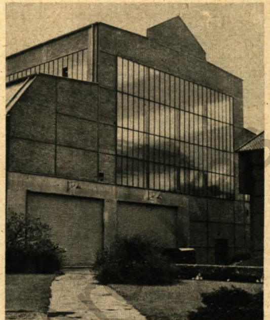
▲ Die Giebelfront der erweiterten Werkshalle mit den beiden Rolltoren, die zwei Einfahrten von je sieben Meter Breite und fünf Meter Höhe freigeben
