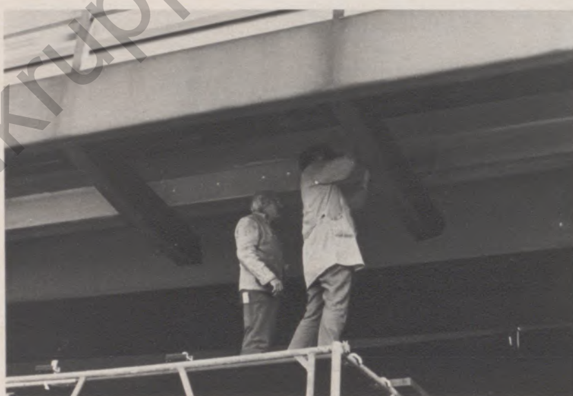
▲ Der Brückenkörper wird mit schalldämpfenden Elementen versehen
