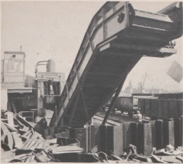
Die umgesetzte Großschrott- Schere
