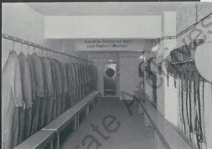
Blick in einen Schutzraum der Einsatzgruppe. Der Raum bietet Schutz vor Splitterwirkung und chemischen Kampfstoffen. An den Wänden wird die Ausrüstung der Männer griffbereit aufbewahrt
