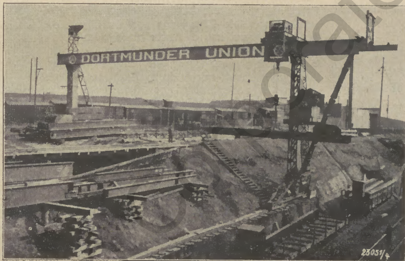
Das Montagegerüst der Dortmunder Union an der „Schnettkerbrücke“
