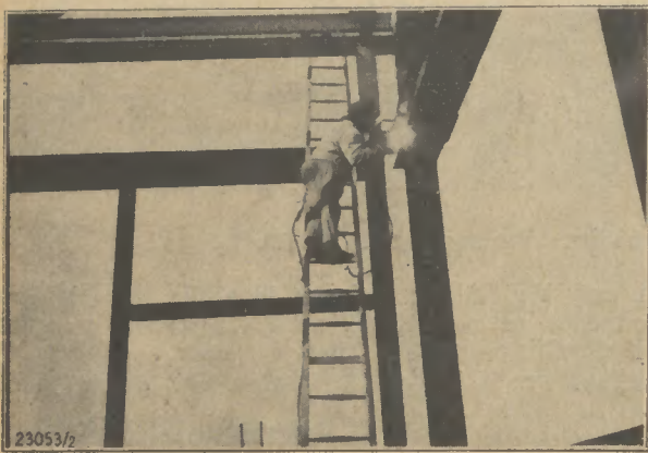
Der Schweißer bei der Arbeit
