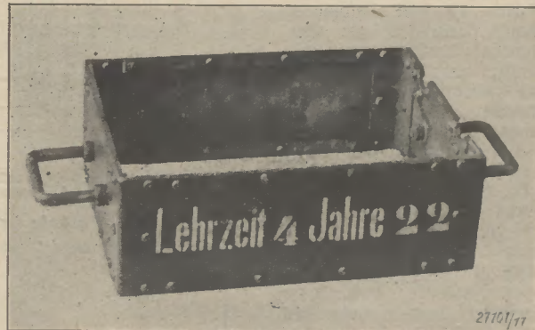
Bild 2. Facharbeit für Bauschlosser: Formkasten (Oberkasten). Ausführung
