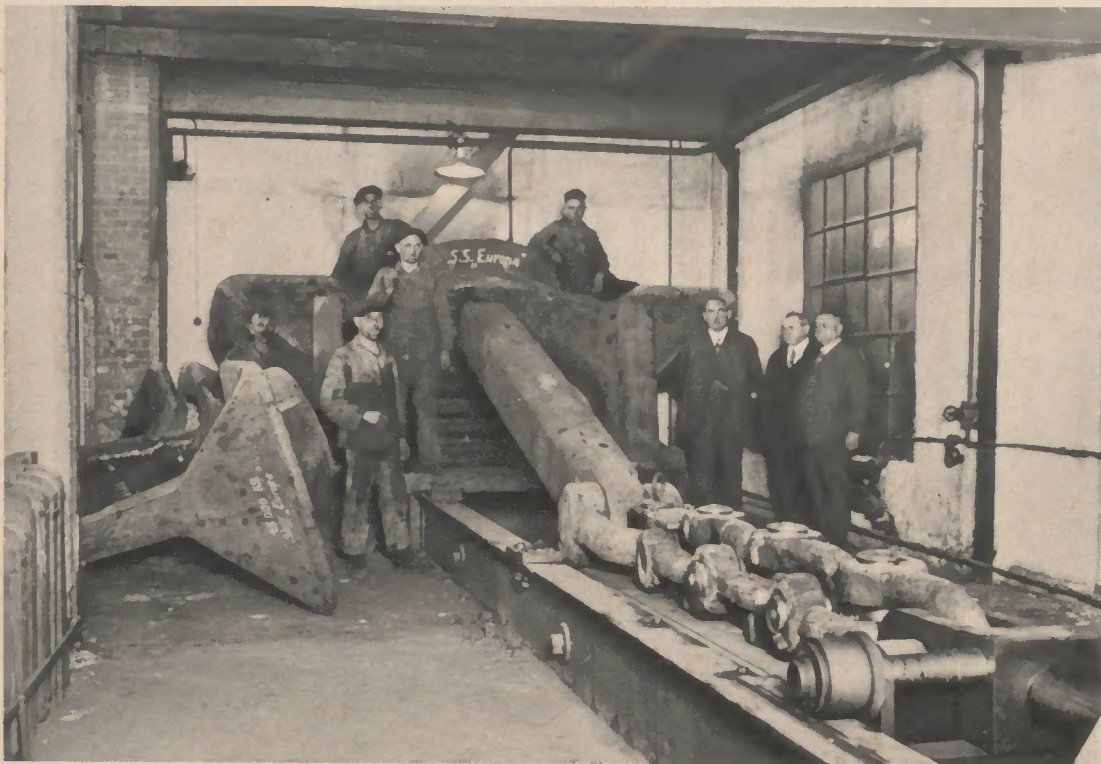
▲ Einer der Union-Becker-Anker für die „Europa“ ist eingespannt für die Zugprobe. Dem „historischen Augenblick“ wohnen bei (von rechts): Betriebsvorsteher Raskop, Expedient Holtmann, ein Abnahmebeamter des Germanischen Lloyd, links vom Ankerschaft (von oben) Schlosser Ponschek, Vorarbeiter Schmittchen und Schlosser Barth
