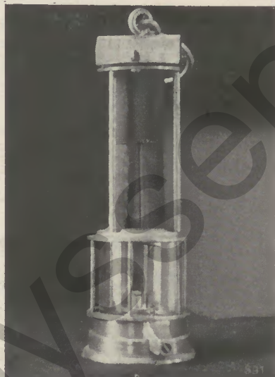
Glanz-Lampe, 1820, durch Einbau eines Glaszylinders verbesserte Grubensicherheitslampe
