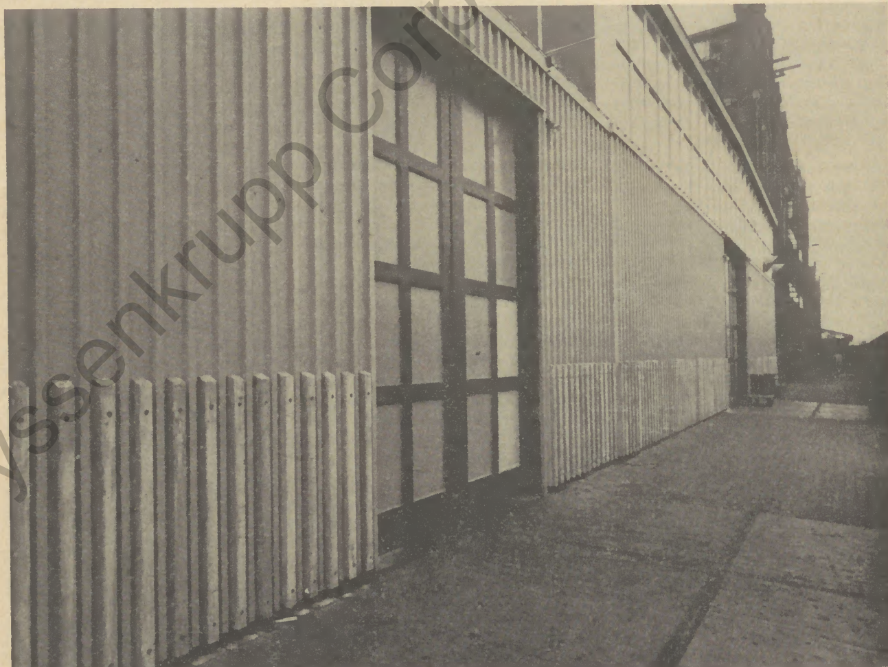
Feuerverzinktes, trapezprofiliertes Blech aus unserer Fertigung als Dach- und Wandverkleidung.
