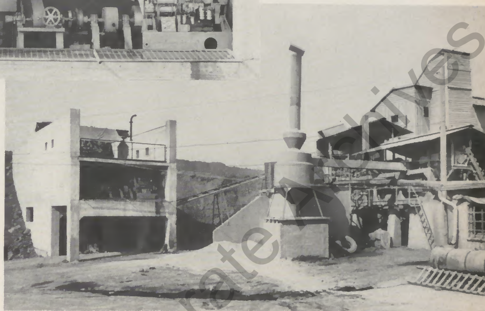
Henschel-Diesel 6 R 1416, 190 PS bei 1400 U/min, als Antriebs-Motor in einem Steinbruch bei Fritzlar. Der Henschel-Diesel ist Antriebs-Motor für den Steinbrecher und zugleich für ein Elektro-Aggregat.
