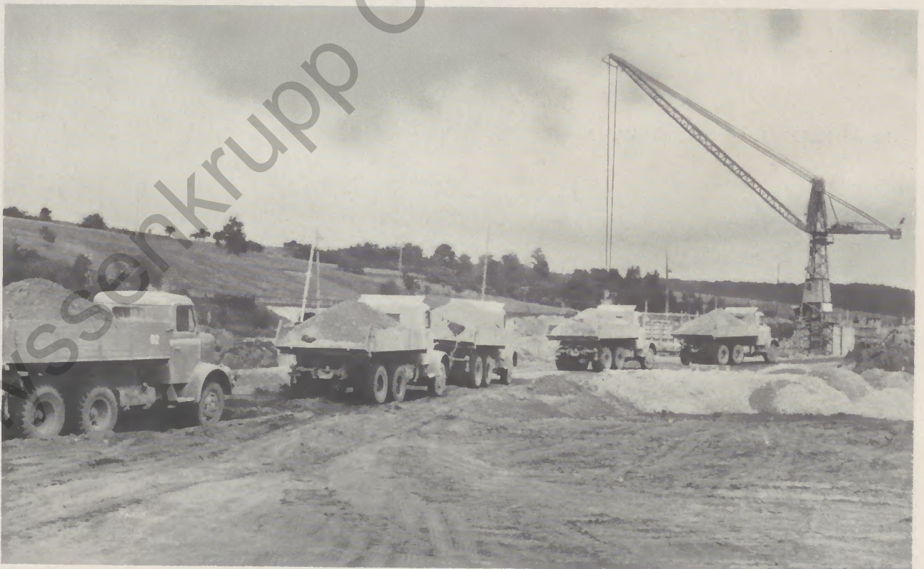
Die Henschel-Kipper im Baugelände
