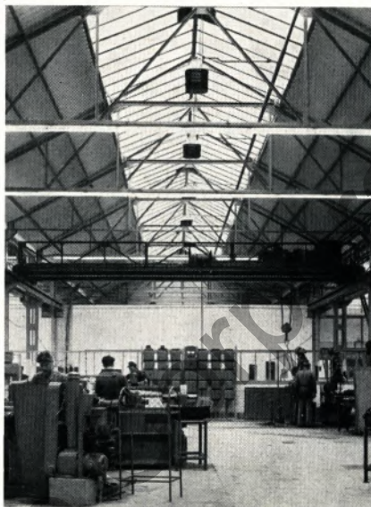
Moderne Licht- und Heizungsanlagen erleichtern das Arbeiten und schützen die Gesundheit der Belegschaft
