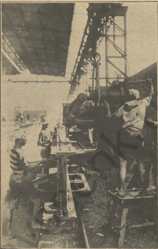
Brückenbauhalle. - Kniehebel-Nietmaschine.
