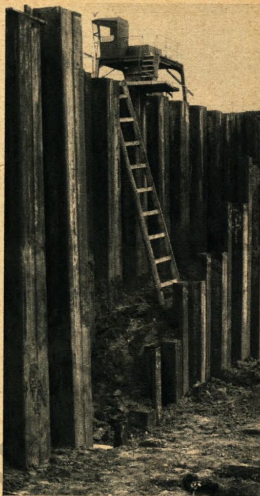
▲ Aus in die Spundwand eingefügten Spundwandkästen, deren vordere Bohlenreihe stufenförmig nachgeschlagen wurde, entstanden die Treppen
